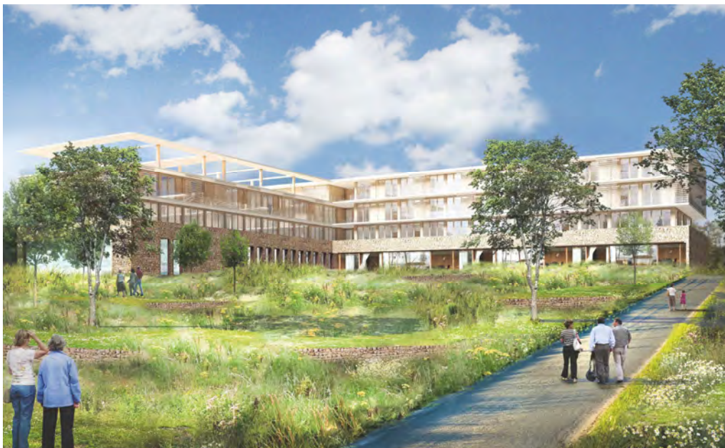
Klinikgebäude ohne Staffelgeschoß
